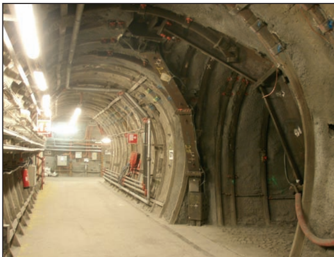
Figure 3 : carrure de la galerie GT6
