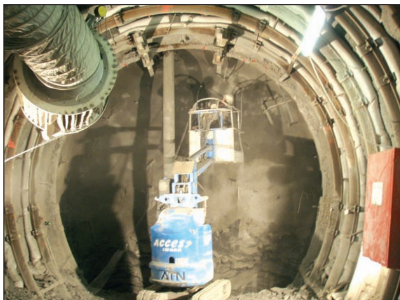
Figure 9 : marin à front après l'excavation Figure 9 : muck at the workface after excavation
