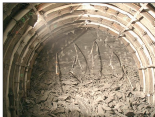
Figure 9 : marin à front après l'excavation Figure 9 : muck at the workface after excavation
