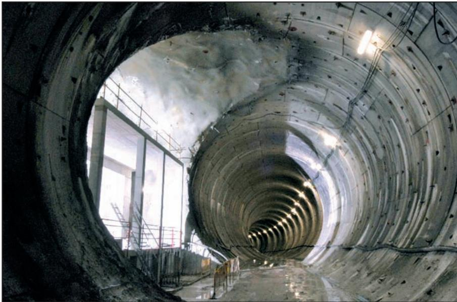
Fig 8 - Intersection du tunnel avec un puits d'accès à une station
