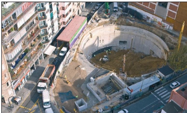
Fig 7 - Puits d'accès creusé à l'abri d'une paroi moulée
