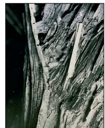
Figure 12 : Déformation des schistes ardoisiers dans la galerie d'amenée en charge Lanoux-L'Hospitalet, au-delà de 300 m de couverture.
