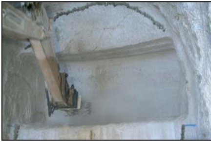
Photo 3 - Fraisage du front avant microminage des bancs rocheux pré-découpés par forages sécants
