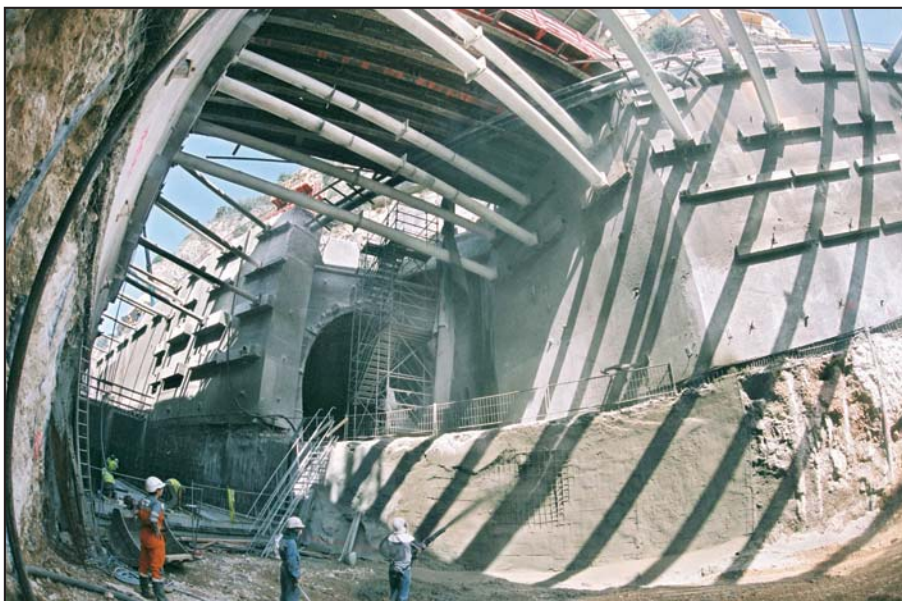
Photo 2 - Tête amont, intersection entre la galerie technique et le tunnel T33
