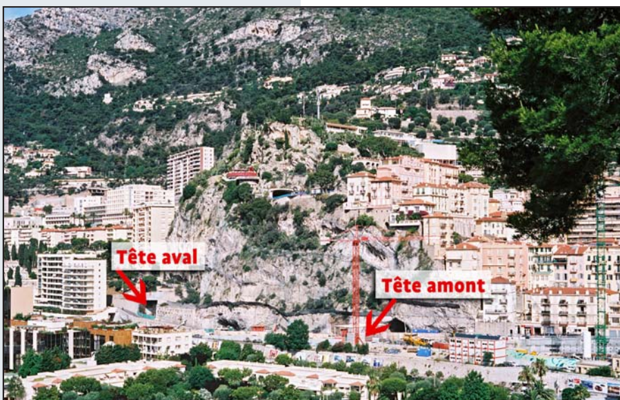
Photo 1 - Le chantier dans son environnement.
