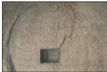
Photo 5 - Une volée prête à être chargée avec ses 141 trous forés et son « bouchon fraisé »
