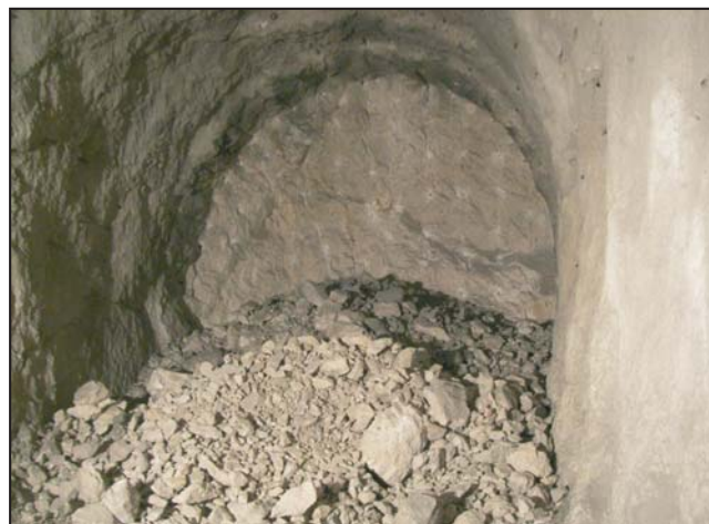
Photo 6 - Le résultat d'un tir de mines en pleine section juste après évacuation des gaz et poussières.
