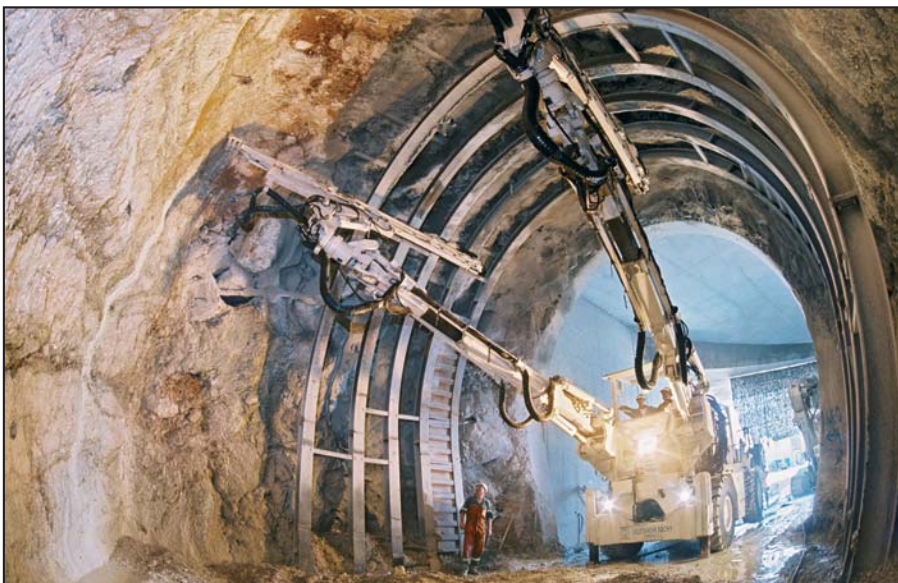
Photo 5 - Une volée prête à être chargée avec ses 141 trous forés et son « bouchon fraisé »
