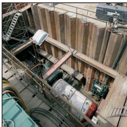
Puits d'attaque du fonçage
