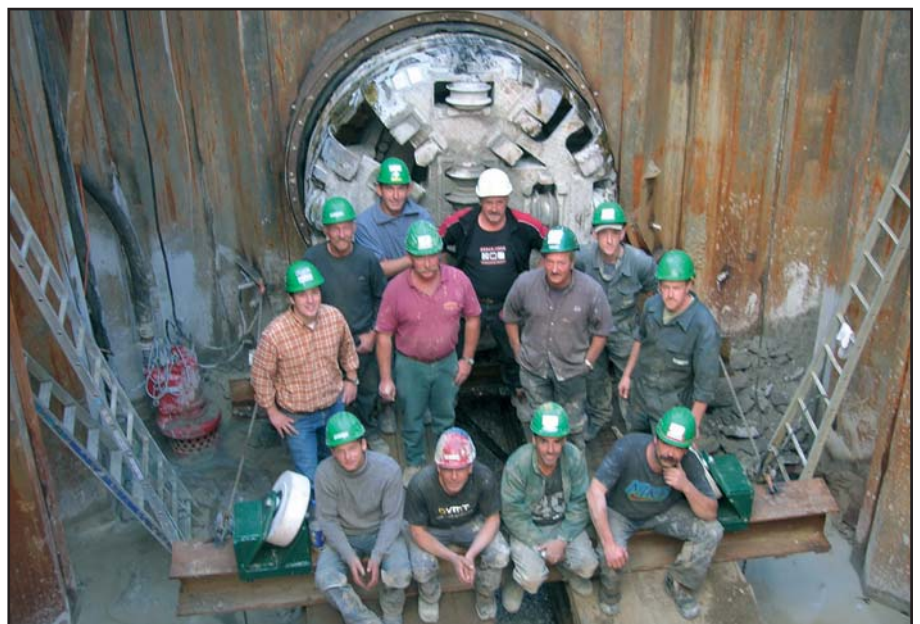
Arrivée du tunnelier dans le puits de sortie.
