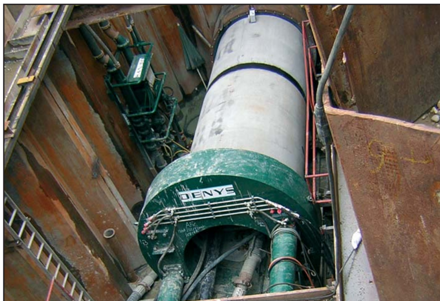
Démarrage du fonçage.
