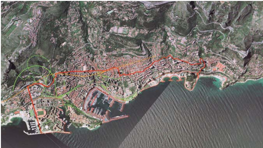
Tunnels et voies ferrées
