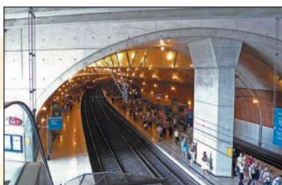
Quais de la gare
