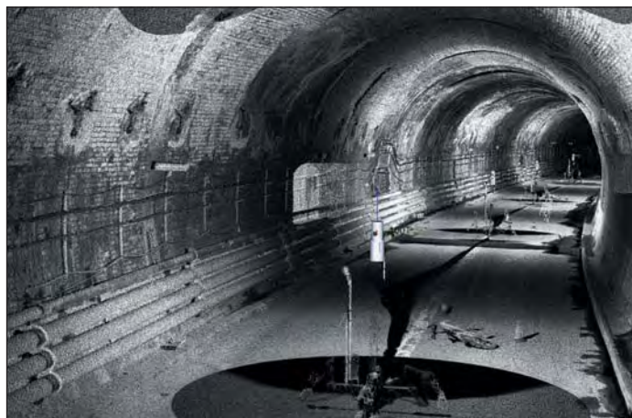
Extrait du nuage de points 3D acquis dans le Tunnel Maurice Lemaire.
