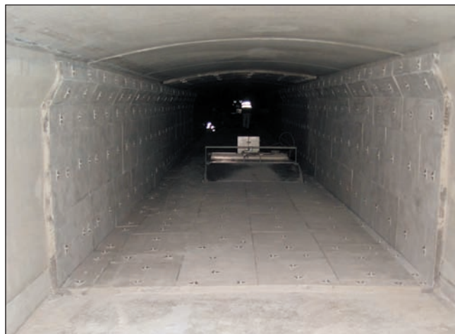
Figure 11 Protection par plaques rapportées
