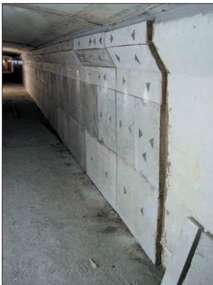
Figure 10 - Protection par plaques rapportées
