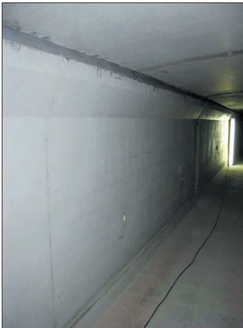
Figure 6 - Joint coupe-feu en tête de cloison
