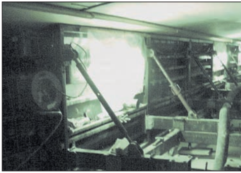
Figure 5 - Coffrage de la gaine de désenfumage
