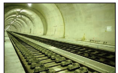
Banquettes latérales de 1,2m de largeur
