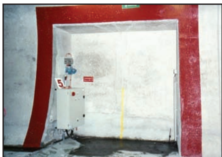
Repérage des niches situées face aux stabilisateurs.
