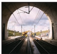
Conduite d'eau d'incendie dans l'axe du tunnel
