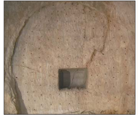
Photo 5 - Une volée prête à être chargée avec ses 141 trous forés et son «bouchon fraisé»
