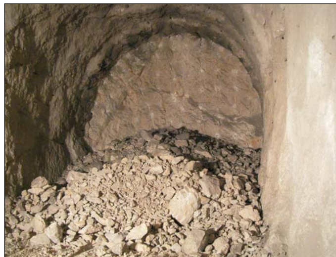
Photo 6 Le résultat d'un tir de mines en pleine section juste après évacuation des gaz et poussières
