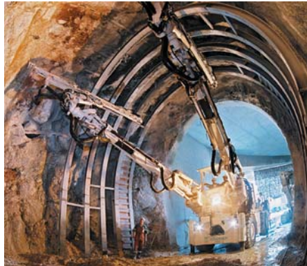
Photo 4 - Le Robofore utilisé pour le creusement depuis la tête aval (Photo Emmanuel Gaffard)
