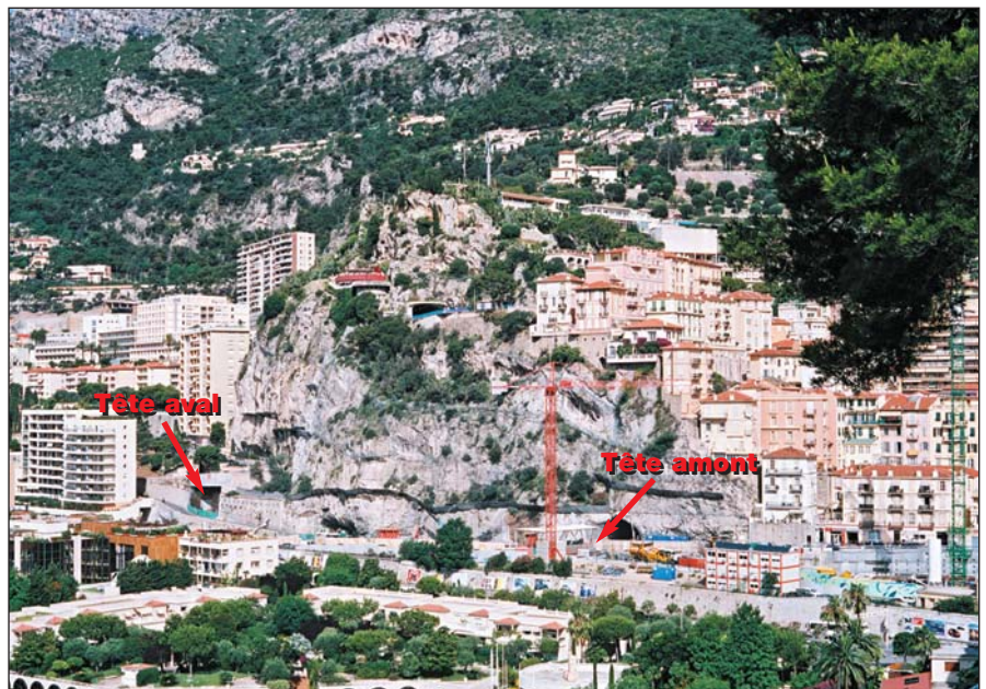
Le chantier dans son environnement (Photo Emmanuel Gaffard)
