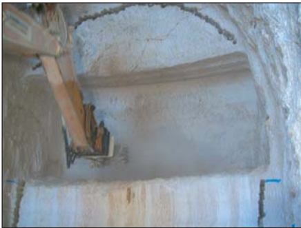
Photo 3 - Fraisage du front avant microminage des bancs rocheux pré-découpés par forages sécants
