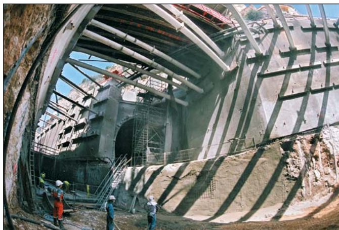
Photo 2 Tête amont, intersection entre la galerie technique et le tunnel T33 (Photo Emmanuel Gaffard)
