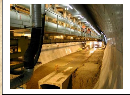
Photo du tunnel en construction
