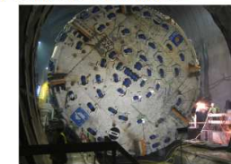
Visite de la galerie de sécurité du Fréjus
