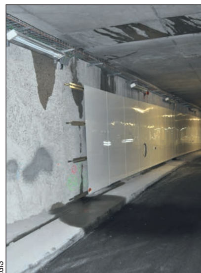
Photo 4 - Chantier test, Tunnel du Prado.
