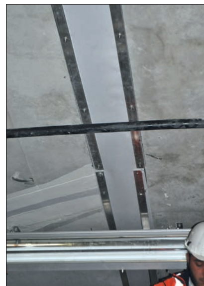
Photo 7 - Joint de dilatation traité par pontage D/NOX – TBS 11.
