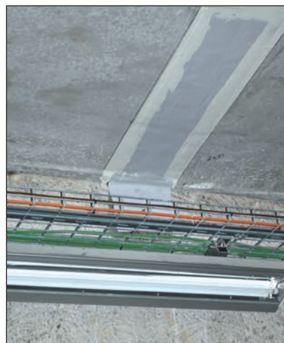
Photo 3 - Pose D/NOX – TBS 10 collé et apparent.
