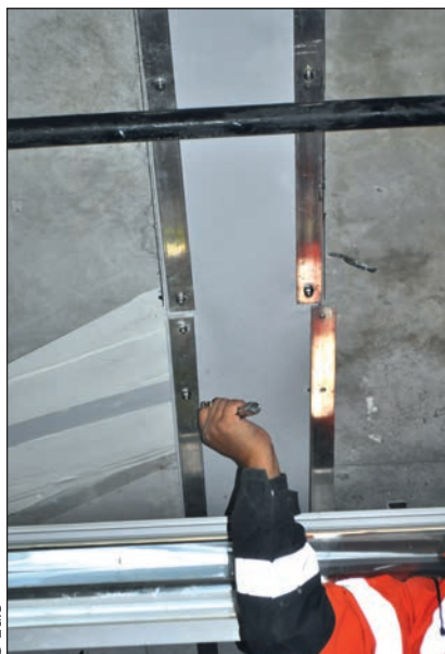
Photo 4 - Pose D/NOX – TBS 11- serrage de la bride.
