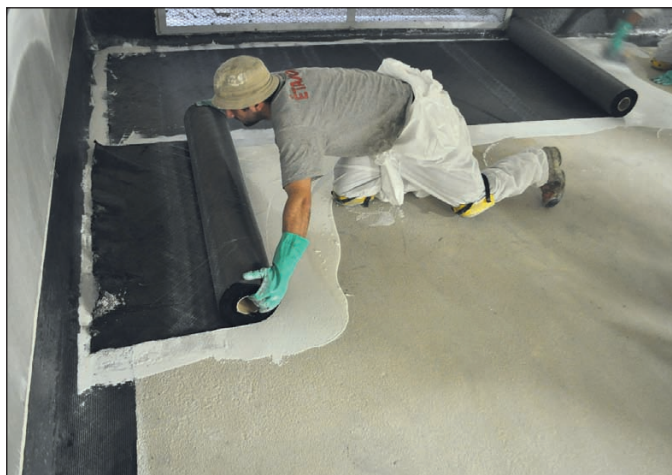
Photo n°3 - Mise en œuvre du tissu de carbone.
