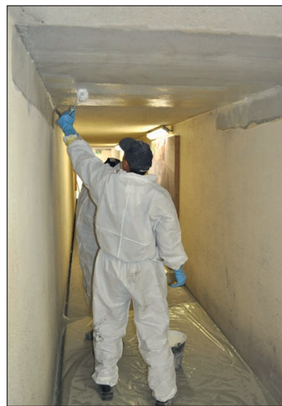
Photo n°5 - Application en sous face de dalle.
