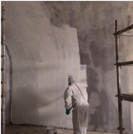
Photo 1 : application de l'imprégnation ETANPRIM SH-V
