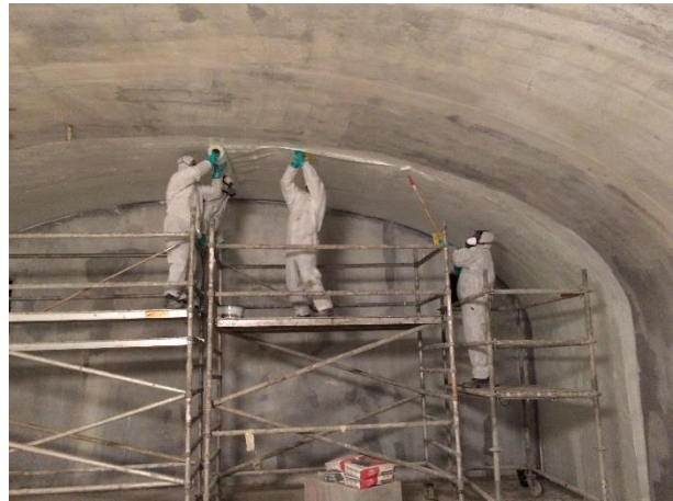
Photo 1 : application de l'imprégnation ETANPRIM SH-V
