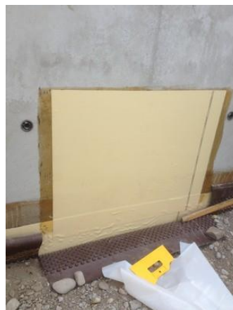
Pose de lé de géocomposite SikaProof® P-12 en extrados de voiles
