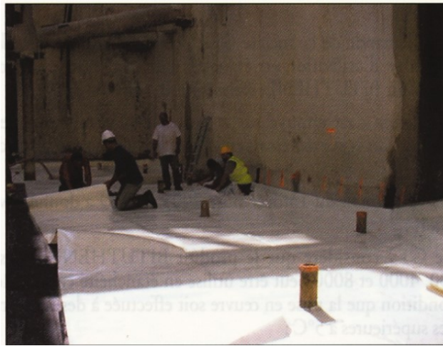
Mise en œuvre du PREPRUFE® 300R
