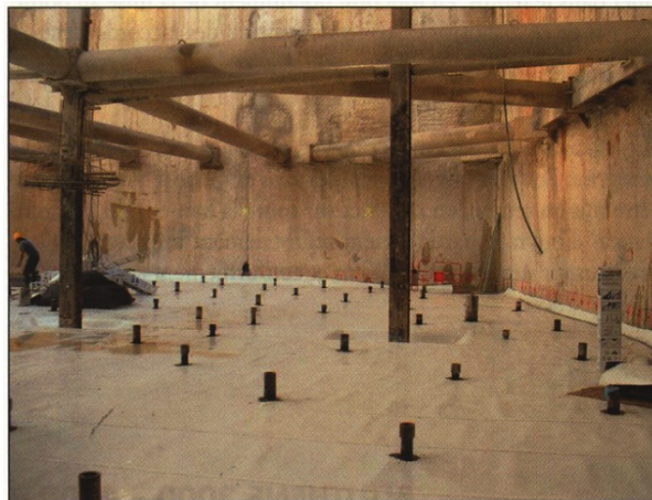
Application du PREPRUFE® 300R sous radier de structure intégrée
