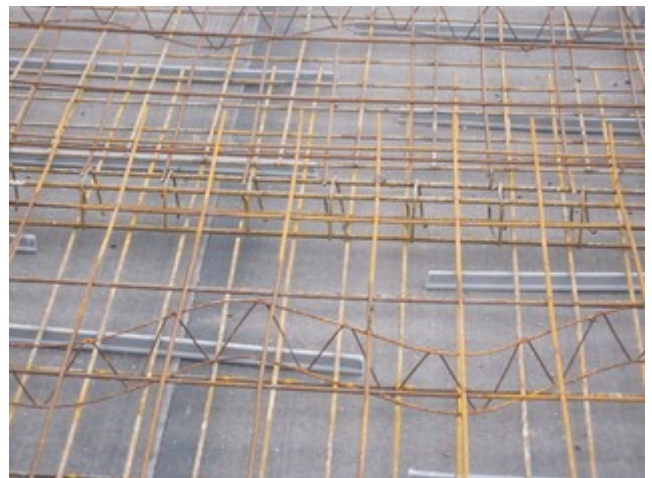
SPI PHENE H CAP sous armatures avant coulage du radier
