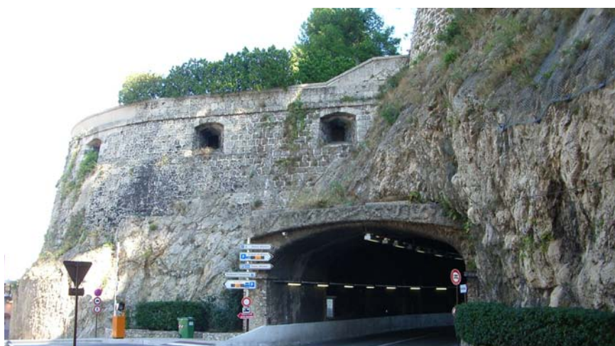
Un tunnel dans le rocher préserve un site historique à Monte Carlo, Monaco
