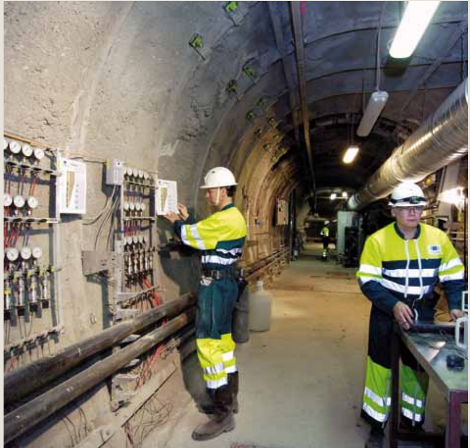
Afin d'étudier le stockage en profondeur de déchets radioactifs de haute activité et de moyenne activité à vie longue, l'Andra a construit à 500 mètres sous terre en Meuse/Haute-Marne un laboratoire de recherche souterrain. © ANDRA / Véronique Paul
