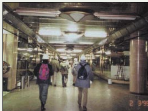
Les structures en élévation sont plus sensibles aux séismes que les ouvrages souterrains - tremblement de terre de Kobé (Japon - 1995) - Importants dégâts pour le bâtiment de la municipalité de Kobé - Aucun dégât pour le centre commercial situé en dessous
