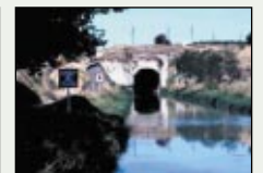
Tunnel du Malpas sur le Canal du Midi (France - Fin du 17 ème siècle)
